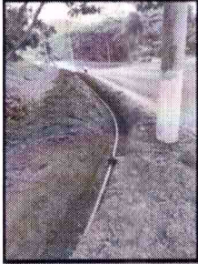
Ampliação da rede de água
