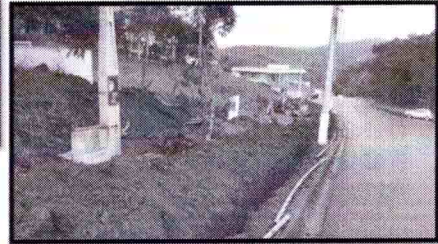
Ampliação de rede de água
