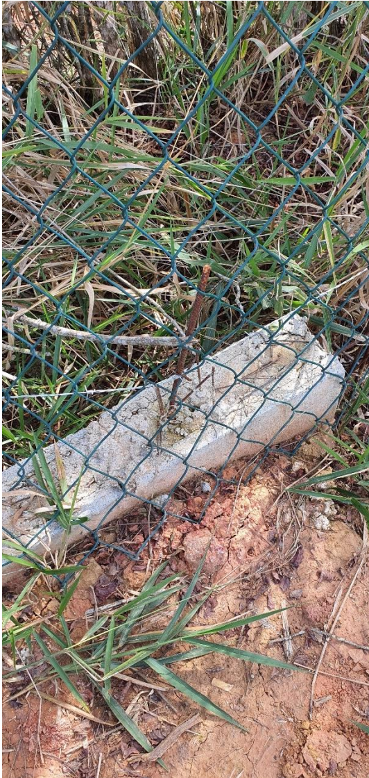
Foto 17 e 18 – Detalhes da fundação construída com blocos canaleta demonstrando o arranque para armação dos pilaretes composto por apenas uma barra de aço, nota-se que a altura do baldrame não chega a 30 cm e tão pouco está “engastada” ao solo.
