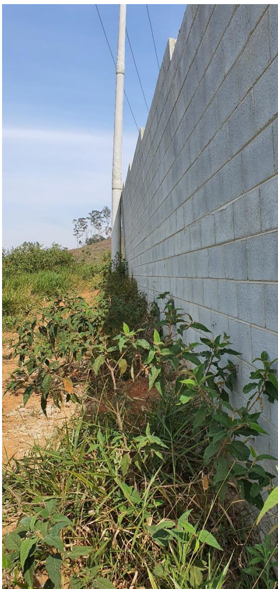
Fotos 32 e 33 – Trecho do muro que ainda não colapsou, no entanto, apresenta inclinação que indica a possibilidade e o risco eminente de desabamento do mesmo.
