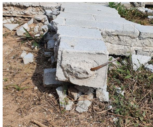
Foto Detalhe 05 e 06 – Pilares (pilaretes) do muro, sem armação composta de barras de aço amarradas por estribos.
