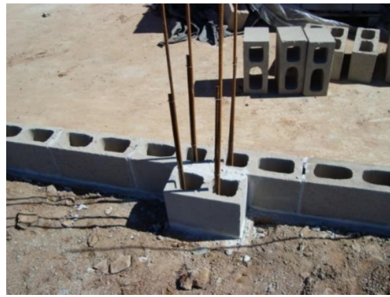
Fotos Detalhe 14 e 15 – Exemplo de pilares utilizando diretamente os blocos de concreto, sem a necessidade de formas.
