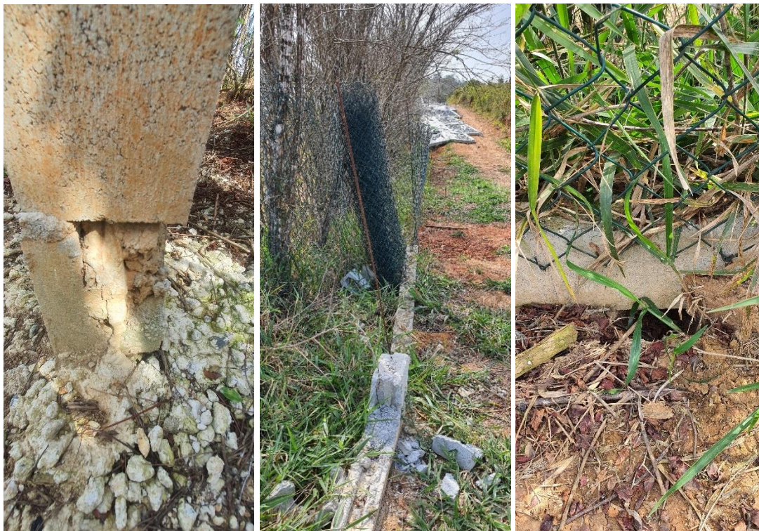
Fotos Detalhe 10, 11 e 12 – Demonstração da viga “baldrame” feito em bloco canaleta.
