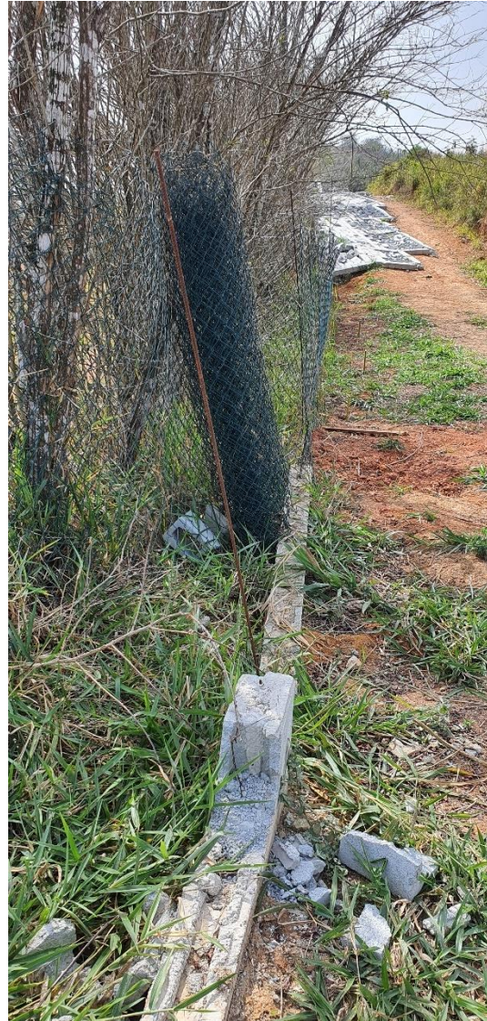
Foto 17 e 18 – Detalhes da fundação construída com blocos canaleta demonstrando o arranque para armação dos pilaretes composto por apenas uma barra de aço, nota-se que a altura do baldrame não chega a 30 cm e tão pouco está “engastada” ao solo.
