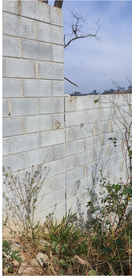
Foto 09 e 10 – Trecho do muro que permanece em pé com detalhe dos pontos deixados como junta de dilatação.
