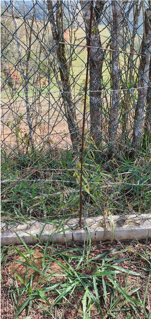
Fotos 24 e 25 – Escombros de trecho do muro colapsado com demonstração da “armadura” utilizada como arranque para construção de pilarete do muro, bem como, demonstração da fundação parcialmente sobre a superfície do solo.
