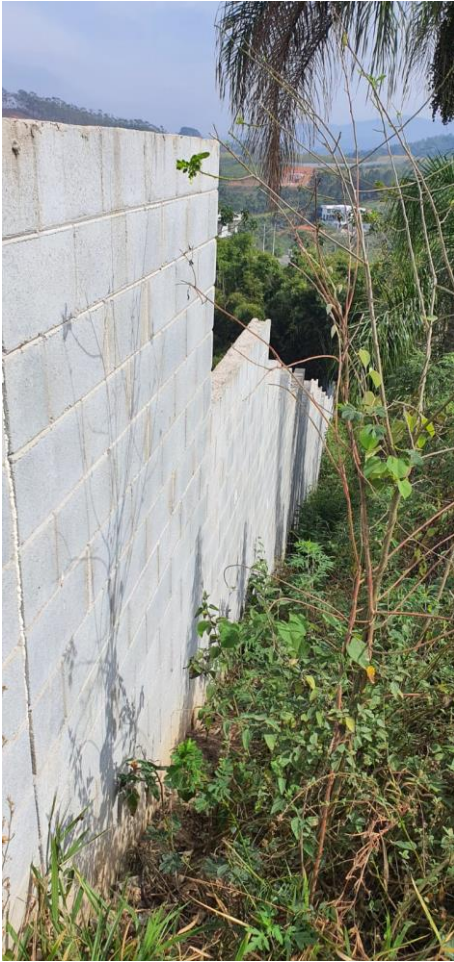
Foto 09 e 10 – Trecho do muro que permanece em pé com detalhe dos pontos deixados como junta de dilatação.
