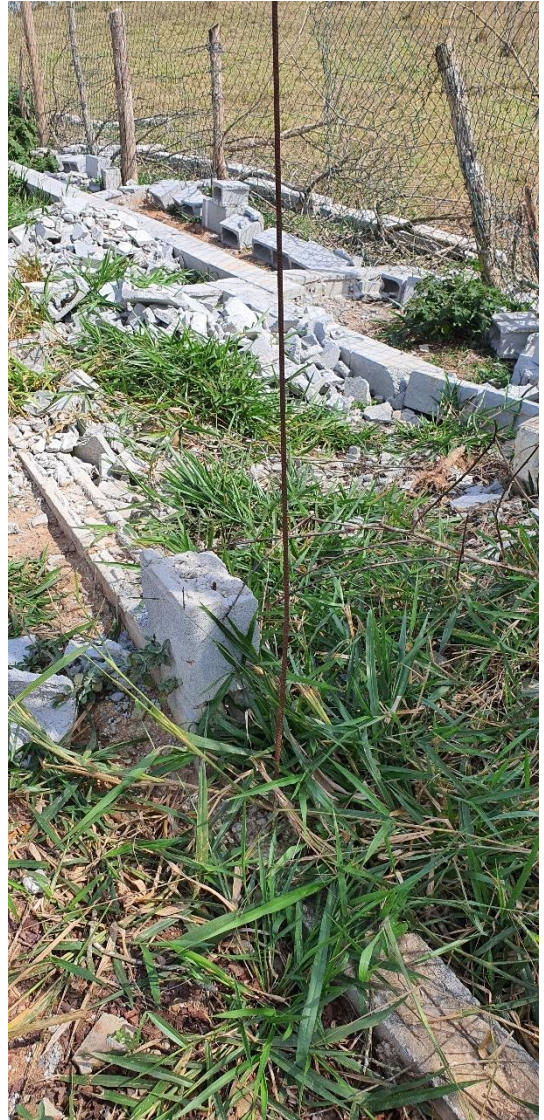
Fotos 24 e 25 – Escombros de trecho do muro colapsado com demonstração da “armadura” utilizada como arranque para construção de pilarete do muro, bem como, demonstração da fundação parcialmente sobre a superfície do solo.
