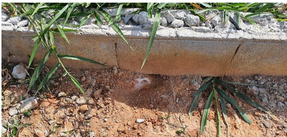
Foto Detalhe 01 e 02 – Baldrame do muro (fundação) em Bloco Canaleta.
