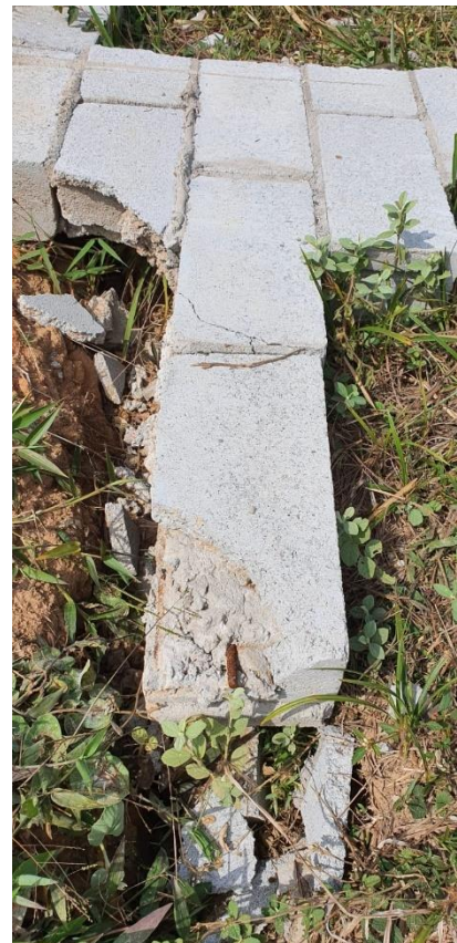
Foto 04 e 05 – Detalhes dos pilaretes de suporte do muro de divisa (foto 04 à esquerda) e a cinta à meia altura do mesmo (foto 05 à direita). Percebe-se que o pilarete possui apenas uma barra de aço, como “armação”, assim como, a cinta é composta de apenas uma barra de aço.
