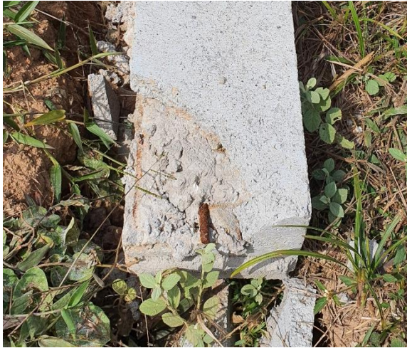
Foto Detalhe 03 e 04 – Cintas de amarração do muro.
