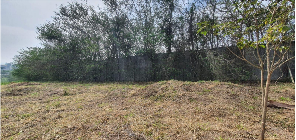
Foto 03 – Continuação do muro existente, construído anteriormente, que está localizado à poucos metros do trecho apresentado na foto 01, e que seria contíguo ao novo muro, esta foto e a anterior estão colocadas com a finalidade de mostrar que apesar do projeto ser responsabilidade da TBS, ela poderia ter usado, no mínimo, o padrão construtivo similar ao muro existente, uma vez que esse era um requisito do Edital.
