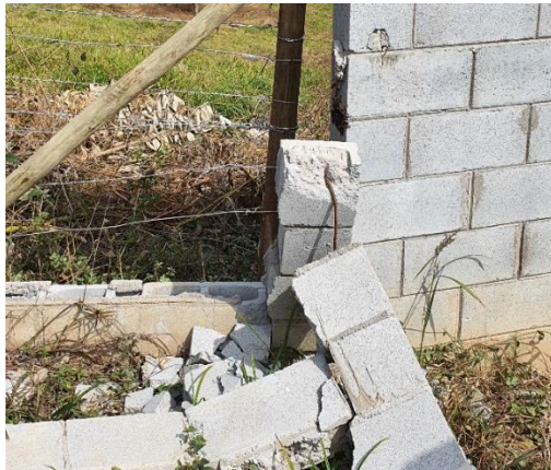
Foto Detalhe 05 e 06 – Pilares (pilaretes) do muro, sem armação composta de barras de aço amarradas por estribos.
