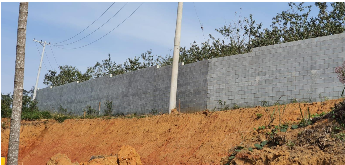
Fotos 32 e 33 – Trecho do muro que ainda não colapsou, no entanto, apresenta inclinação que indica a possibilidade e o risco eminente de desabamento do mesmo.
