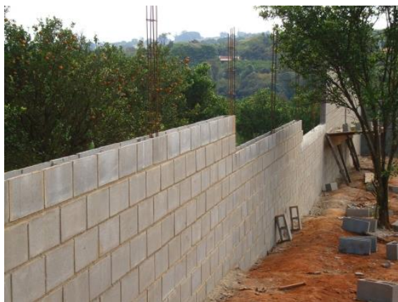
Fotos Detalhe 14 e 15 – Exemplo de pilares utilizando diretamente os blocos de concreto, sem a necessidade de formas.
