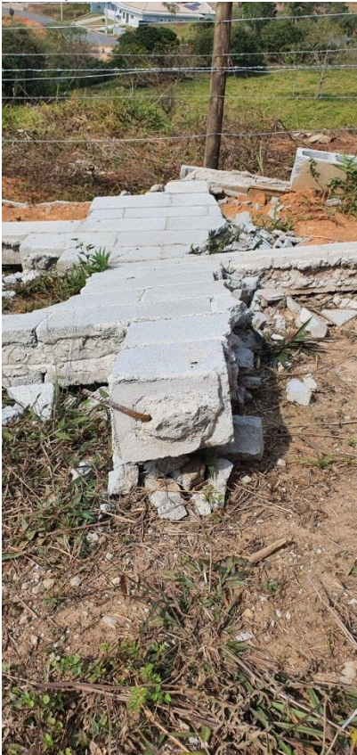
Foto 04 e 05 – Detalhes dos pilaretes de suporte do muro de divisa (foto 04 à esquerda) e a cinta à meia altura do mesmo (foto 05 à direita). Percebe-se que o pilarete possui apenas uma barra de aço, como “armação”, assim como, a cinta é composta de apenas uma barra de aço.
