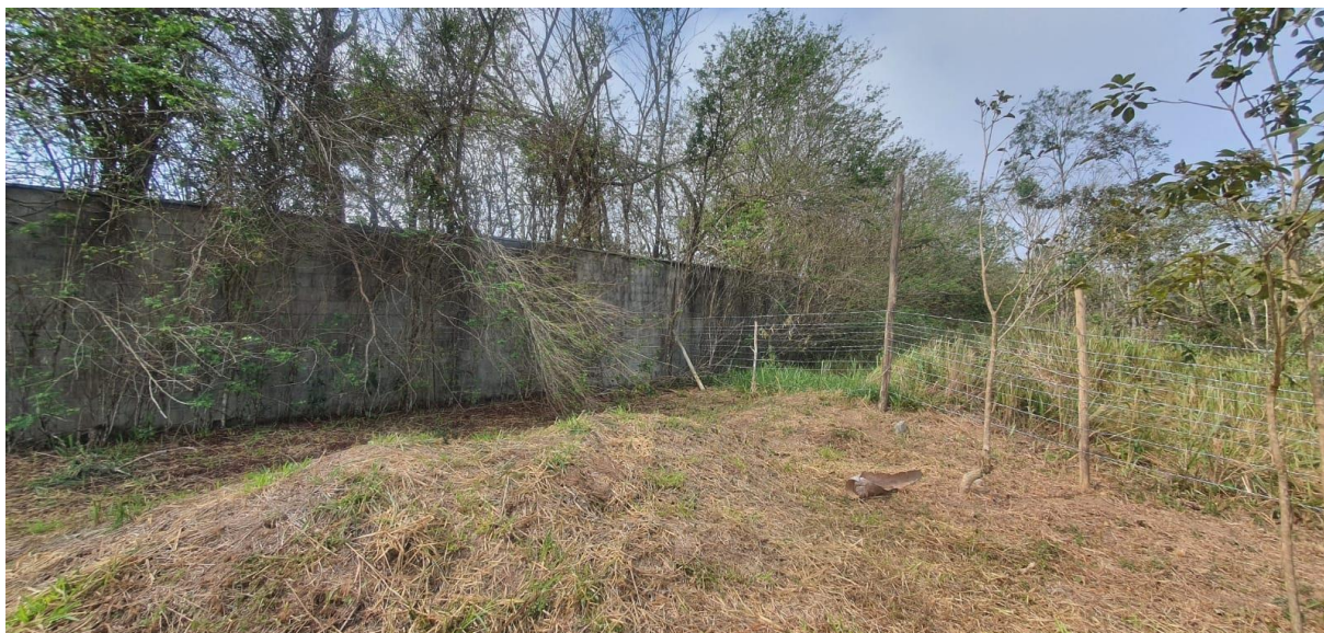
Foto 02 – Trecho do muro existente, construído anteriormente que estava localizado à poucos metros do trecho apresentado na foto 01, que seria contíguo ao novo muro.
