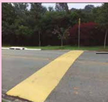
Execução de lombadas
