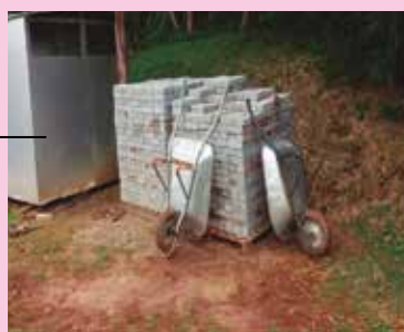
Piso intertravado, calçadas e execução do deck
