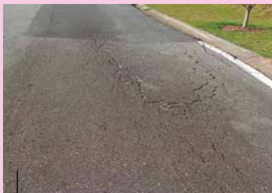
Manutenção no asfalto priorizando áreas de trincas que sofriam infiltrações
