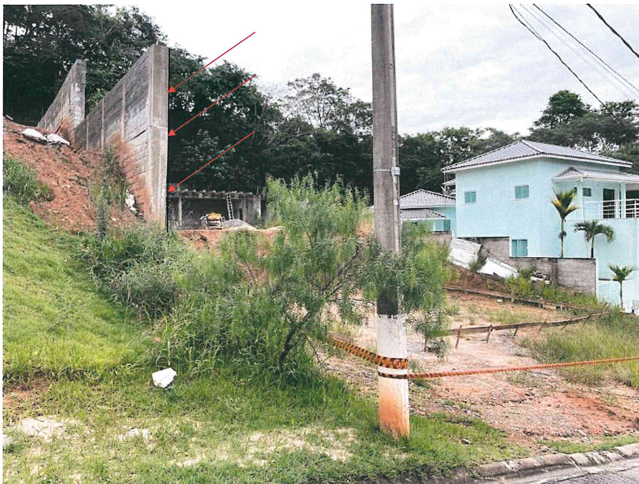
Imagem 1: Local em análise. Evidente inclinação.
